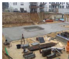
November 2018 Die Aushubarbeiten für Tiefgarage und Untergeschoss sind beendet. Aus der Baugrube wird eine Baustelle.
