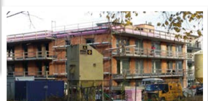
November 2019 Fenster und Türen sind seit Oktober drin, der Innenausbau läuft nun auf Hochtouren.
