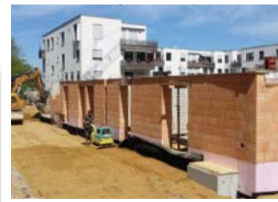
April 2019 Es geht in die Höhe - die Mauern des Erdgeschosses wachsen.
